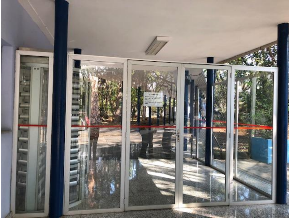
Foto 3: Porta e fechamento em vidro
